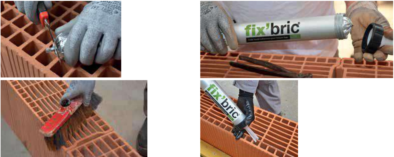
Figure 15 Pose du procédé fix'bric S - 2 cordons
