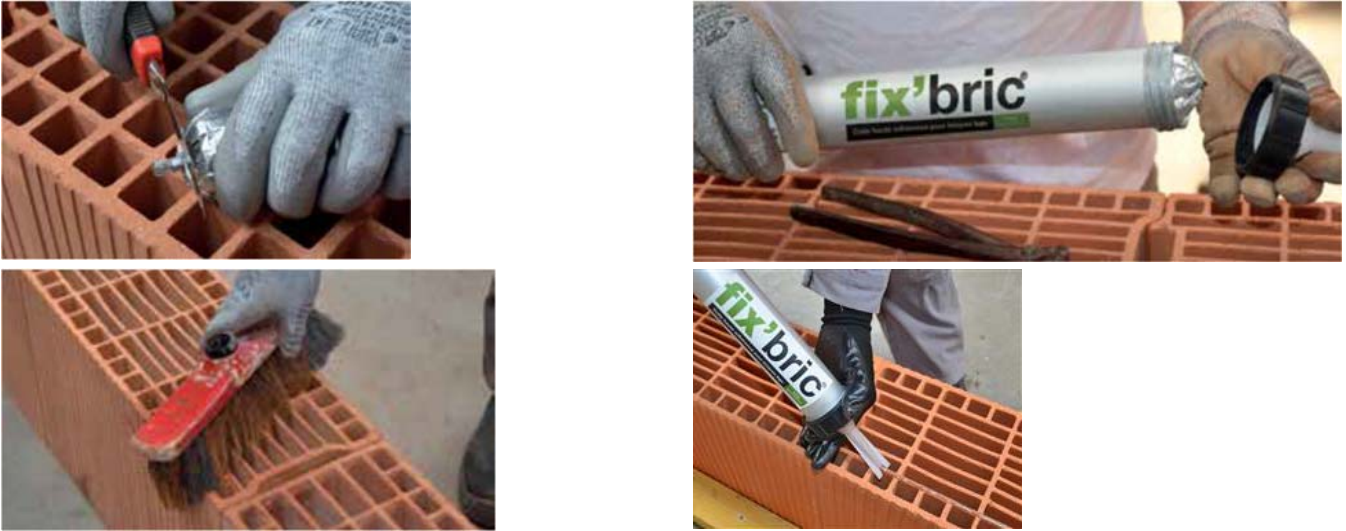
Figure 4 Préparation pour la pose du procédé fix'bric N
