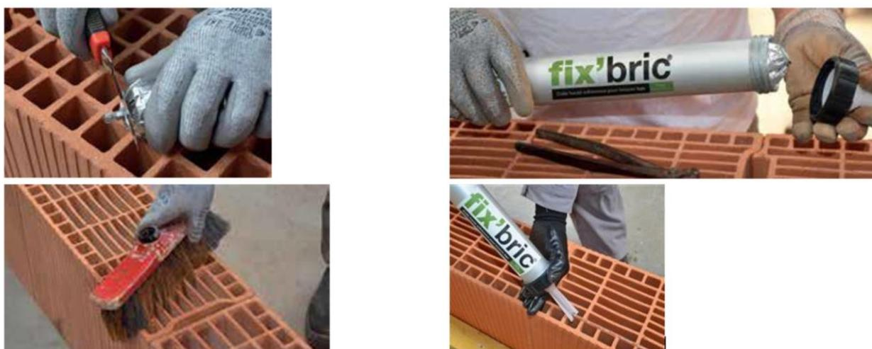
**Figure 14 : Préparation pour la pose du procédé fix'bric**
