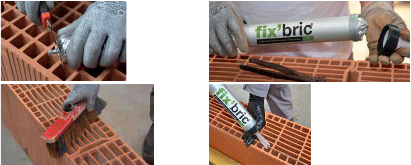
Figure 14 Pose du procédé fix'bric N - 2 cordons
