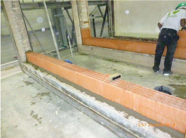
Pose de la première rangée de briques sur lit de mortier
