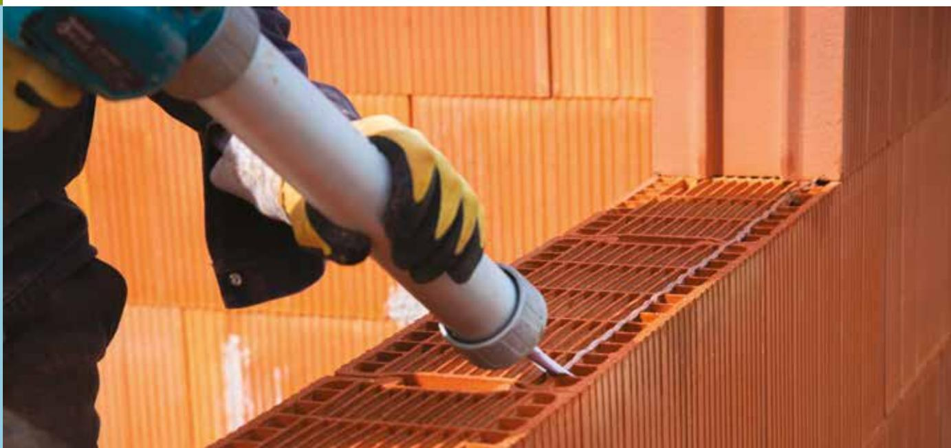
**fix'bric est un liant polymère hybride prêt à l'emploi pour l'assemblage durable des briques rectifiées de la gamme bgv<sup>20</sup> en maison individuelle.** Cette colle est disponible en poche de 600 ml pour pistolet manuel ou électrique. L'embout/canule fix'bric permet la dépose rapide et précise des cordons de colle sur les parois de la brique.
