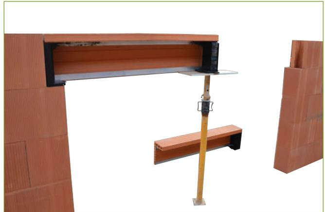
Réglez la hauteur de coffrage et mettez en place des serre-joints afin de rigidifier l'ensemble et assurer l'alignement.
