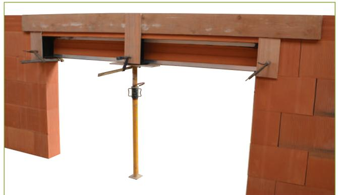
Afin de renforcer la liaison du linteau avec le coffre, cassez l'alvéole supérieure du coffre pour y placer un ferrailage en forme de crochet.
