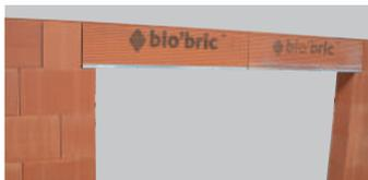
La réalisation d'un 1/2 CVR abouté est nécessaire quand la largeur de l'ouverture est supérieure à 3,50 m.
