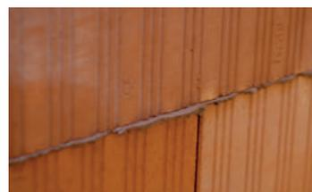
Humidifiez la brique. Attendez 5 min avant la dépose du mortier.
