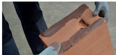
En zone sismique, graissez les parties verticales à la truelle avant la pose.
