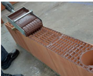
Déposez le mortier joints minces à l'avancement (2 ml maxi). Réduisez la longueur en cas de forte température ou forte pluie.
