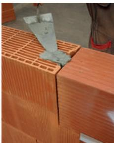
Scellez le coffre au moyen d'un béton de clavetage en créant un évidement dans la brique adjacente.
