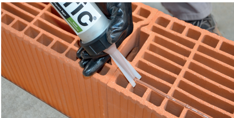
Dépose de fix'bric sur la paroi
