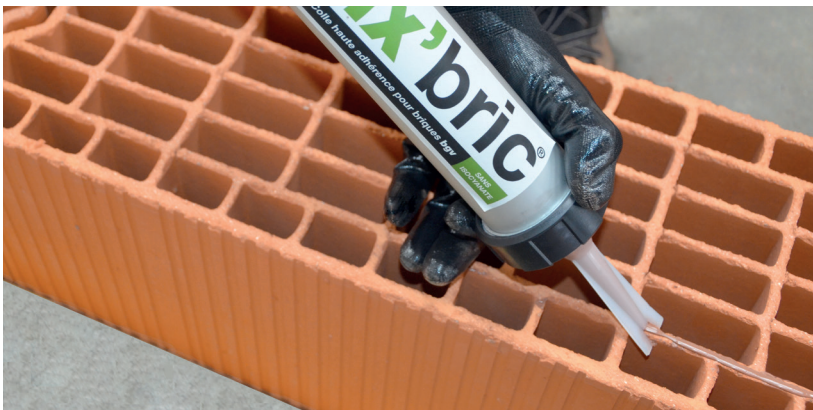
Dépose de fix'bric sur la paroi
